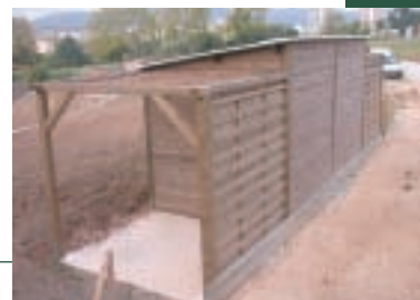
Bavette d'étanchéité en bas de l'abri
